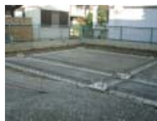
12月末現在の現場。基礎地中梁の施工が終わり、乾燥養生中です。
